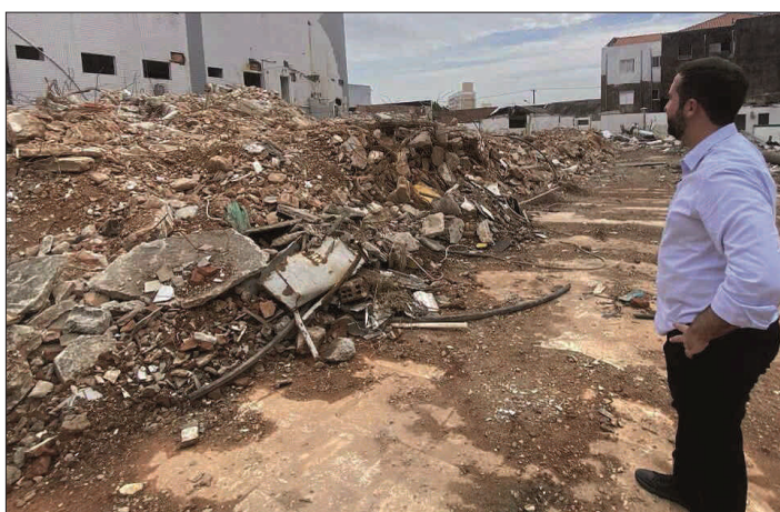
Kayo Amado acompanha demolição do CREI
