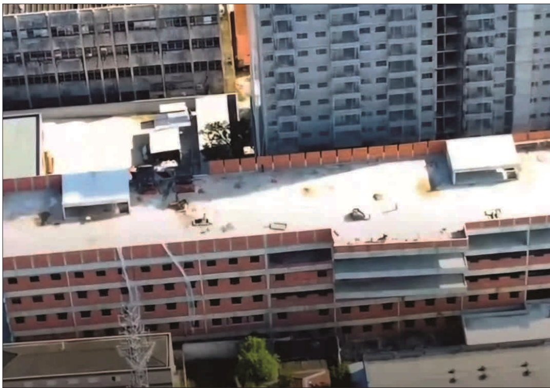
Construção da nova maternidade de SV está a pleno vapor
