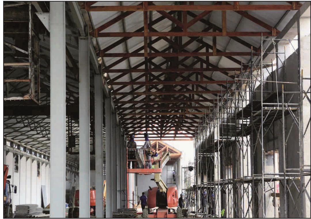
Obras no antigo Armazém 4 estão bem avançadas
