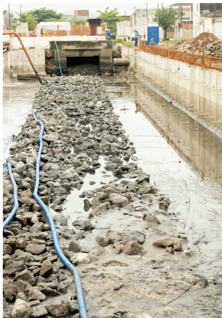
Obras no canal da Eduardo Souto
