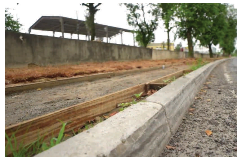
Obras de reurbanização da Linha Vermelha.
