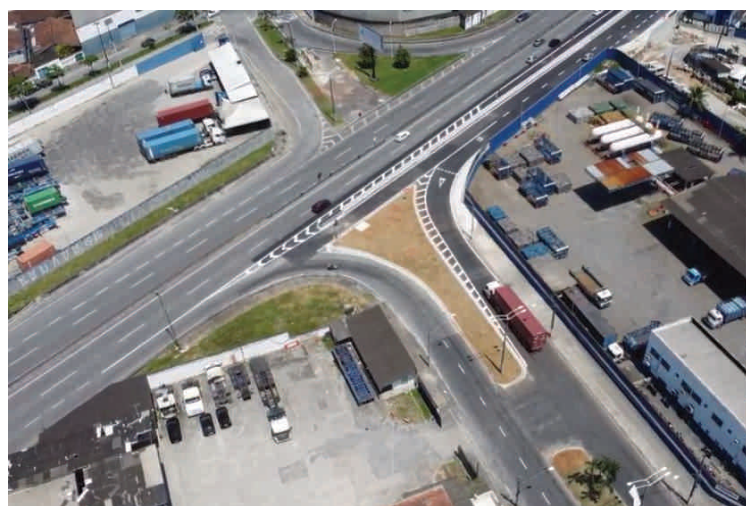
Construção da alça de acesso à imigrantes na Cidade Náutica.
