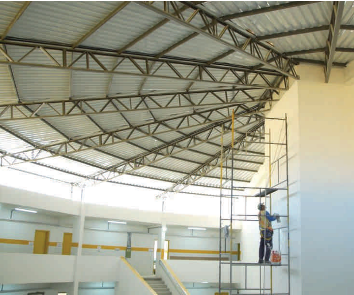
Escola Duque de Caxias, no Jardim Guaçu, entra na reta final das obras de revitalização.
