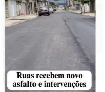
Meta é pavimentação do Dique das Caixetas
