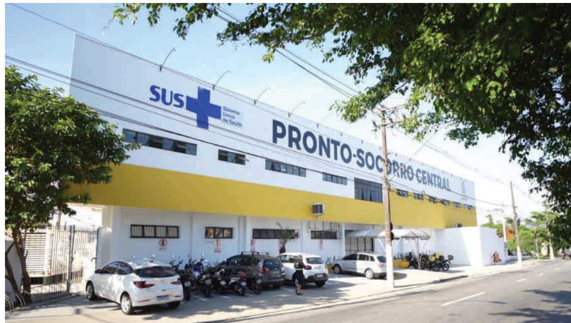
PS Central provisório já está funcionando na Linha Amarela
