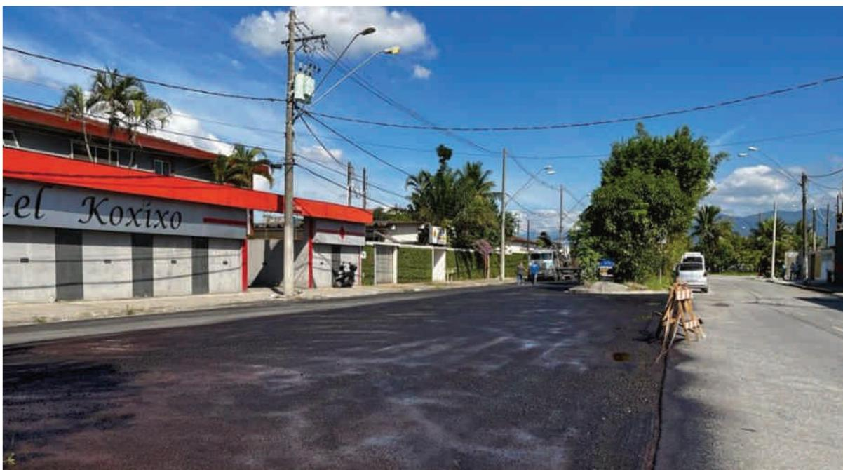
O trecho sentido Rodovia Imigrantes foi contemplado com a execução de recape, que consiste na remoção do asfalto desgastado para que o novo pavimento seja adicionado.
