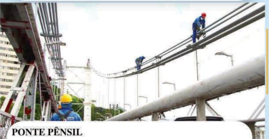
A revitalização da Ponte Pênsil segue avançando e, recentemente, foram concluídas as obras preliminares de recuperação provisória do piso de madeira da estrutura. A substituição definitiva do piso está prevista para ser iniciada em janeiro e concluída em maio.
