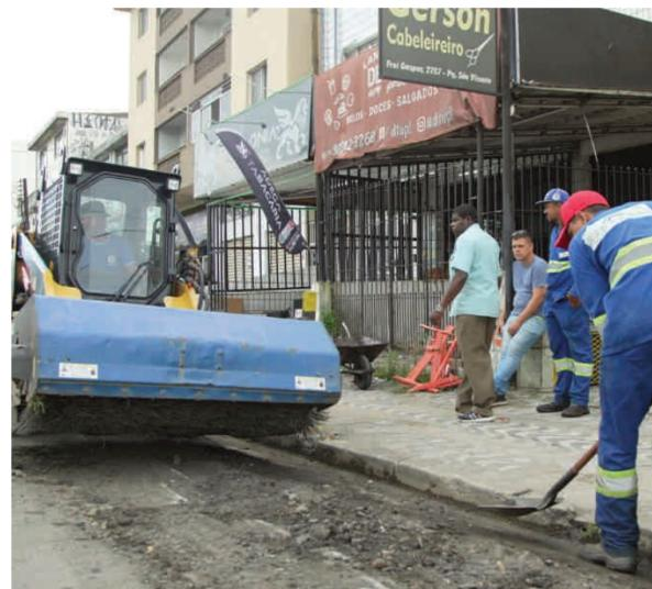
O trecho é contemplado com a execução da fresagem, que consiste na remoção do asfalto desgastado para que o novo pavimento
