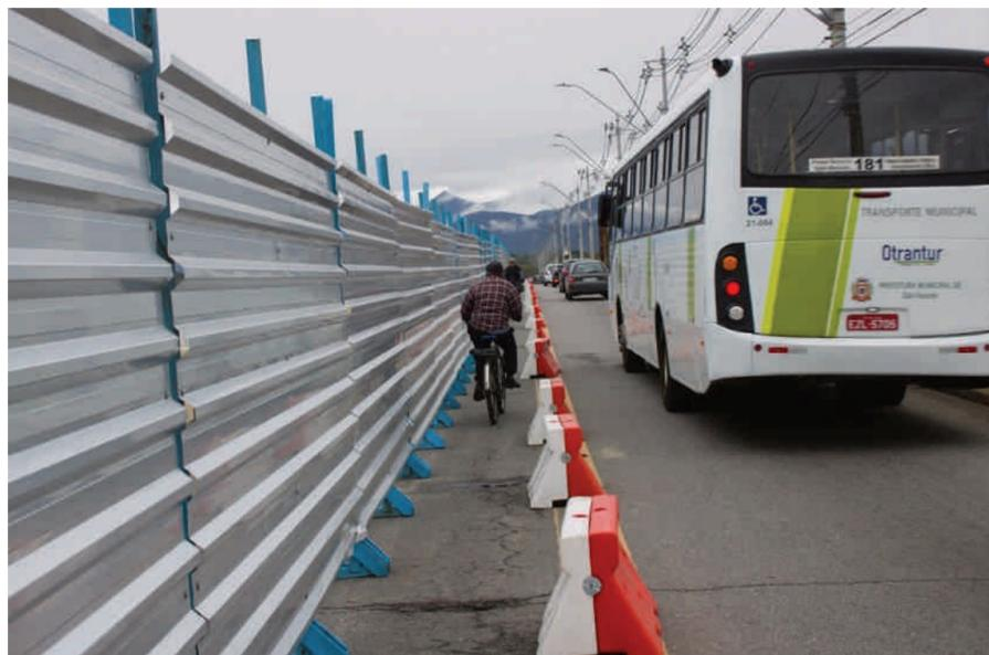
"Vamos terminar de instalar os tapumes metálicos e na segunda-feira (16) vamos iniciar a recuperação da passarela, instalação dos equipamentos que vamos utilizar e montagem da plataforma que vai ficar por baixo da ponte, permitindo que os funcionários façam a recuperação das vigas, longitudinais, transversais e as estacas que fazem a sustentação da ponte", explicou o secretário.
