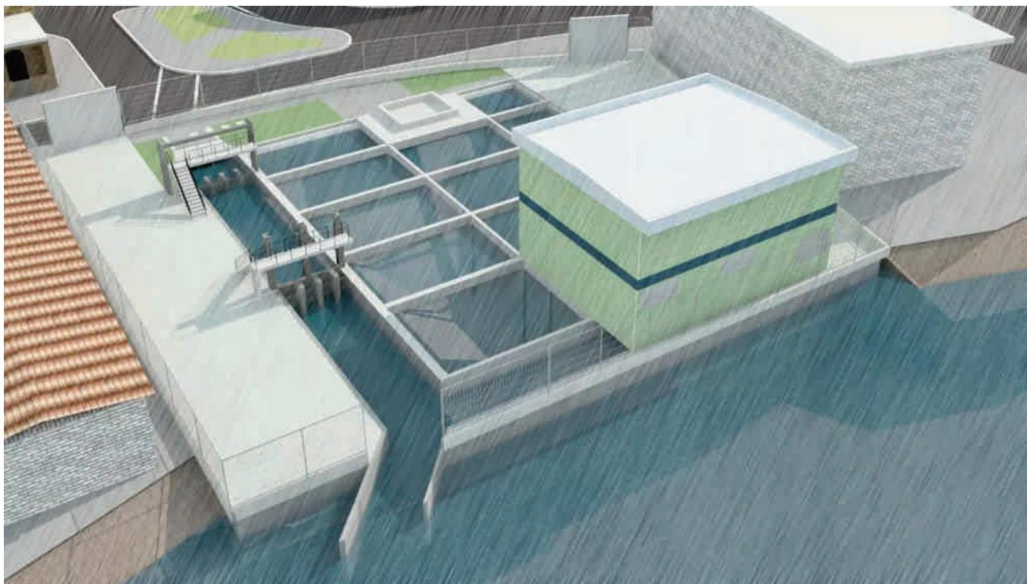
Para conter todo o lixo que é levado com a chuva, o que provoca entupimentos no sistema e dano ambiental, a estação elevatória contará com um dispositivo no canal de deságue. Serão implantados cestos e grades para reter o lixo, em ambos os lados das comportas, todos em aço inox 316L
